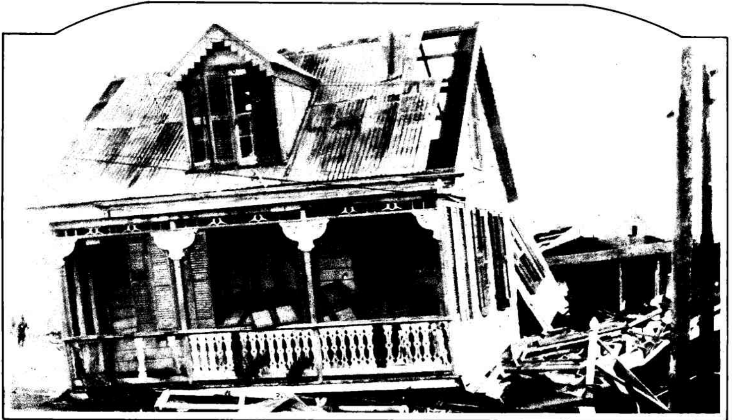
La residencia de Mr. Henry Staunton, vicecónsul de los Estados Unidos en Belice. El huracán transportó la casa a veinte metros de su emplazamiento, y Mr. Staunton resultó gravemente herido.
