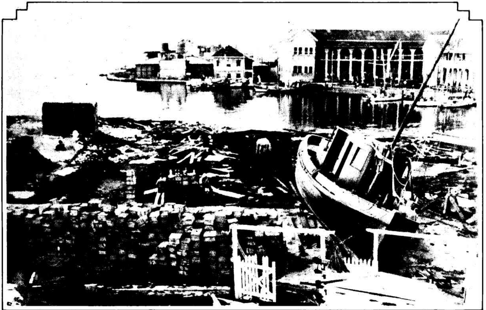
Un aspecto de los muelles, sobre el río Belice. El yate que aparece a la derecha estaba fondeado en el centro del río. El edificio que se ve al fondo es uno de los pocos que no sufrieron daños.
